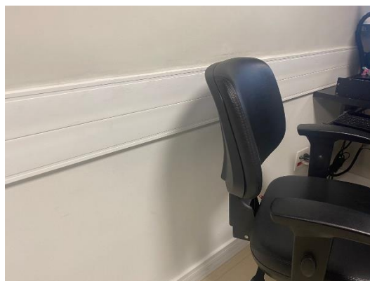
Foto 02: Protetor de parede instalado
